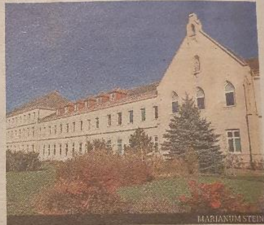
Die Umbauarbeiten beginnen sofort mit Schulschluss. Marianum Steinberg
